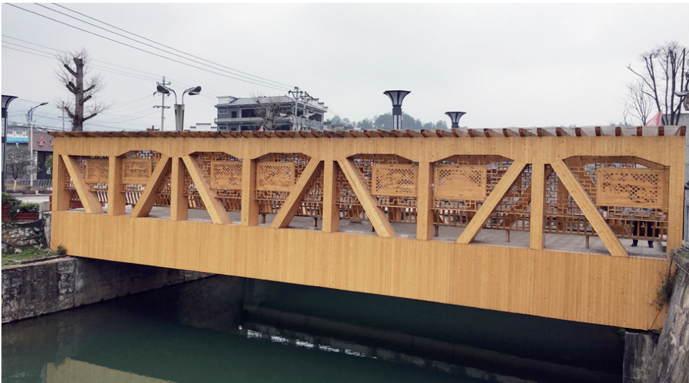
↑如今横跨在敖溪河上的一跨钢架桥
