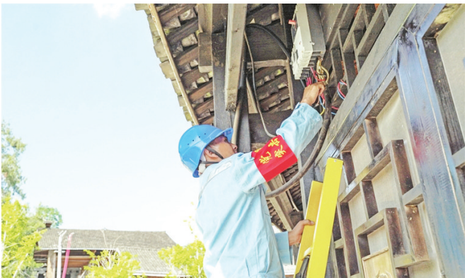
连日来,务川自治县供电局大坪街道供电所组织党员工作人员对龙潭古寨景区电力线路进行巡查检修,以确保用电安全。(吴浩宇 王君辉 摄影报道)
