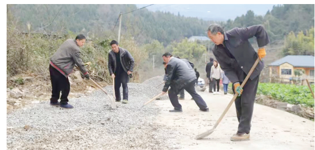
为了方便村民出行,余庆县教溪镇指挥村大坪顶村民组发起倡议,筹集资金实施通组公路扩建。倡议得到该村民组村民的响应,70余户村民自筹资金3万余元,计划将3米宽通组公路扩至5米,预计扩宽长度1公里。(记者 一丁 摄)
