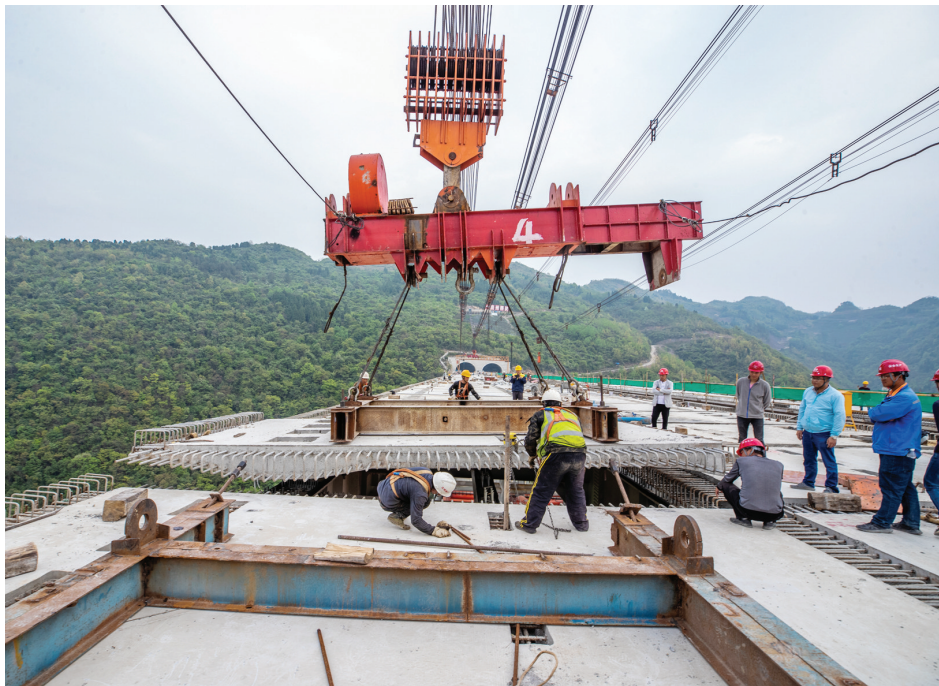
桥面合龙现场
