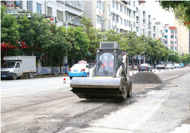
凤冈县以党建为引领,不断优化县城区市政道路及下水管网建设,提升市民生活质量。图为近日在县城迎新大道,工人在作业。(饶云 李国莲 摄影报道)
