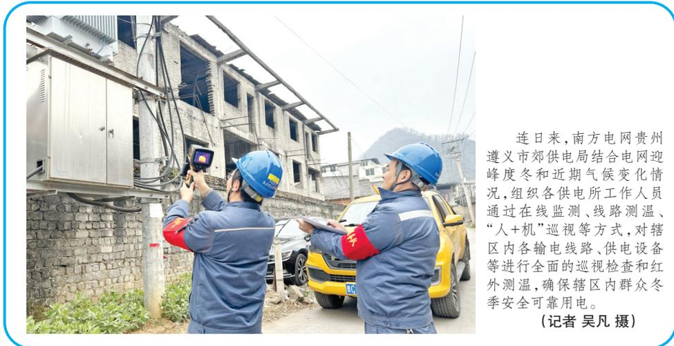
连日来,南方电网贵州遵义市郊供电局结合电网迎峰度冬和近期气候变化情况,组织各供电所工作人员通过在线监测、线路测温、“人+机”巡视等方式,对辖区内各输电线路、供电设备等进行全面的巡视检查和红外测温,确保辖区内群众冬季安全可靠用电。
