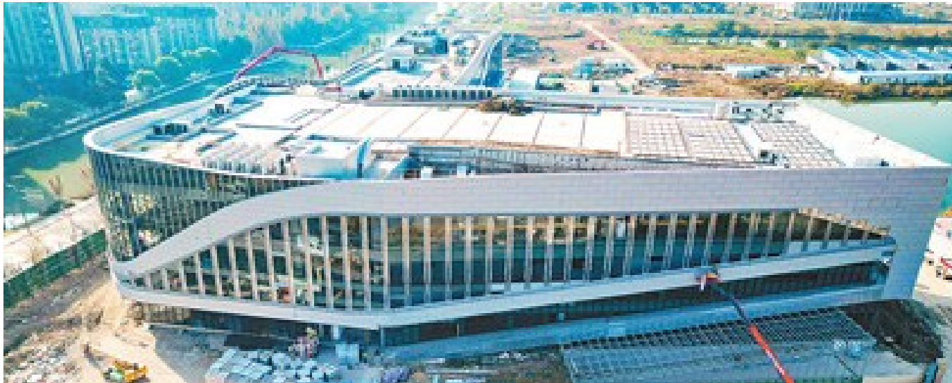
近来,江苏昆山各重点工程项目抢修工期赶进度,确保如期完成各项任务目标。图为建设者在昆山市淀山湖全民健身中心进行外玻璃幕墙安装收尾工作。
