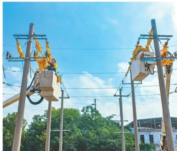
近日,国家电网安徽省芜湖市供电公司、芜湖市繁昌区委总工会举办繁昌区委2025年电力应急保障供用电服务技能竞赛,助力地方技能人才队伍建设和电力应急保障发展。图为参赛选手在参加配网不停电作业比赛。 鲁君元摄(人民视觉)
