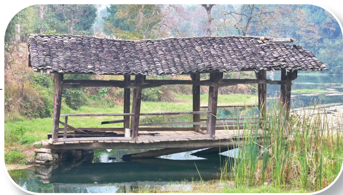
→ 张斗坝凉桥。(金泉泉 摄)
