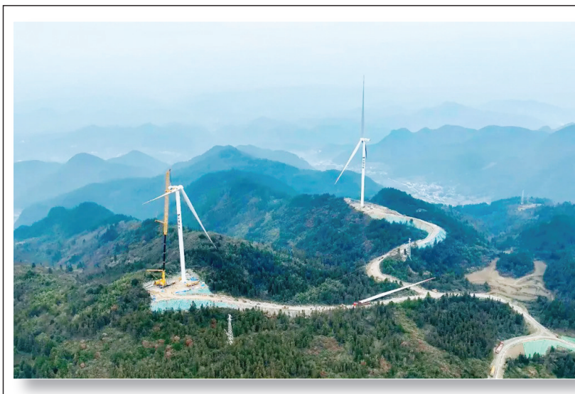
近日,凤冈县花坪一期5万千瓦风储项目在永安镇启动风机吊装,标志着项目建设进入施工关键阶段。据了解,该项目总投资约3亿元,共布置9台风机,总装机容量5.625万千瓦。建成后,预计年发电量达9104万千瓦时,每年可实现产值约3000万元。
