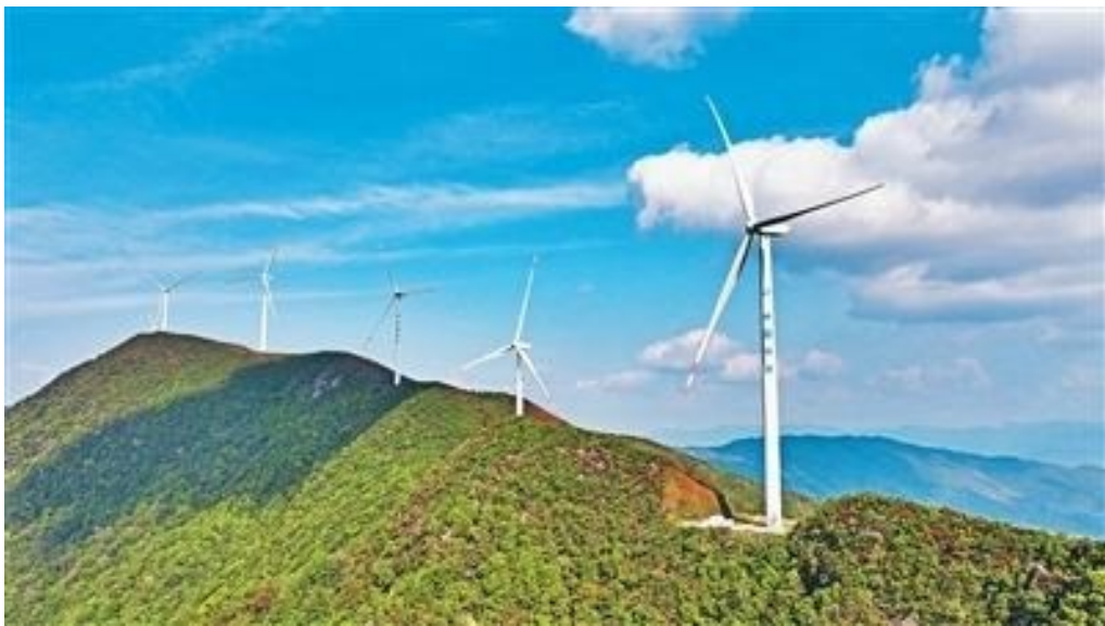
↑江西省吉安市永丰县陶唐乡高龙山风电场的风电机组。 刘浩军摄(人民视觉)
