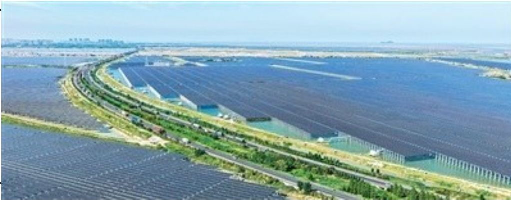
江苏连云港三峡青口盐场渔光互补光伏复合项目现场。 司伟摄(人民视觉)
